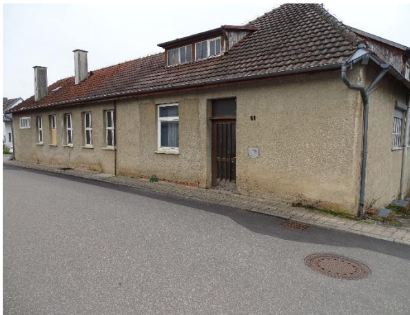
Abb. 3: Nordansicht Werksgebäude Hindenburgstraße 51
