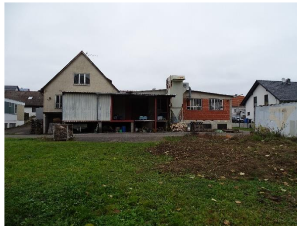
Abb. 4: Südansicht Werksgebäude Hindenburgstraße 51
